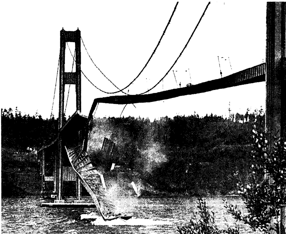
FIGURA 16.20 Puente Tacoma Narrows al colapsarse el 7 de noviembre de 1940. (Usada con permiso de la División de Colección Especial, de la Biblioteca de la Universidad de Washington. Foto de Farguharson, negativo número 12.)
